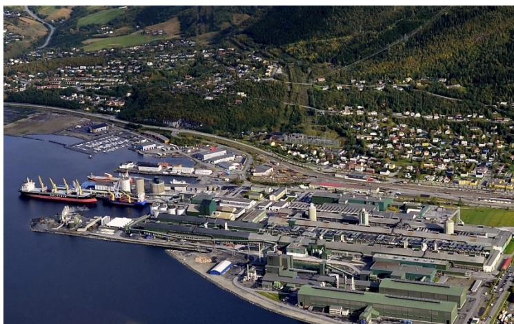
Figur 21 Industribygg uten tilgjengelig areal for installasjon av solcellemoduler pga. struktur og piper på taket. Total arealutnyttelse 0%.
