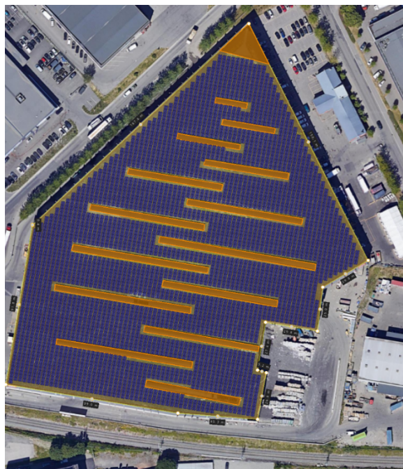
Figur 20 Solcellemoduler lagt på Norges største industri-takflate på 26 000 m 2 . Total arealutnyttelse på 60%.
