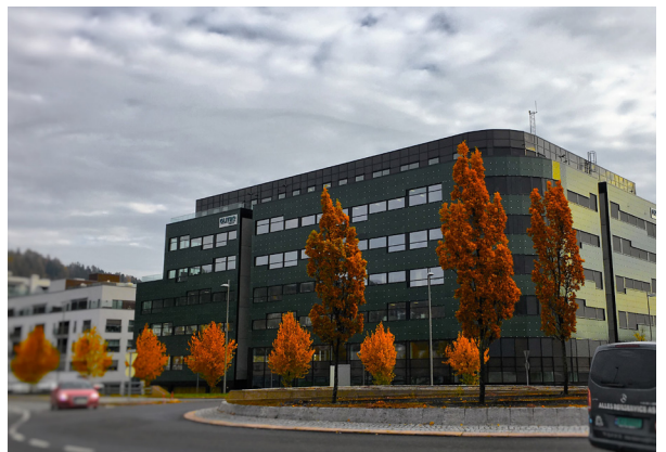
De grønne fasadeplatene på Solsmaragden er solcellepaneler. Foto: Union Eiendom, Monique Anne Marchand
